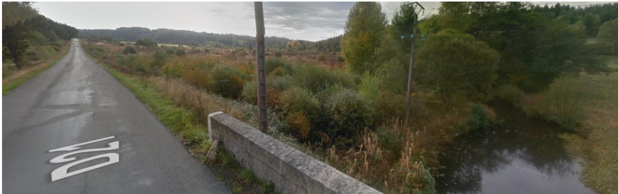
Figure 2 : Vue de la D21 au niveau du passage de la Diège (Google Street View)
